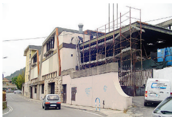
Lavori in corso alla Ghidini Cipriano di Lumezzane
