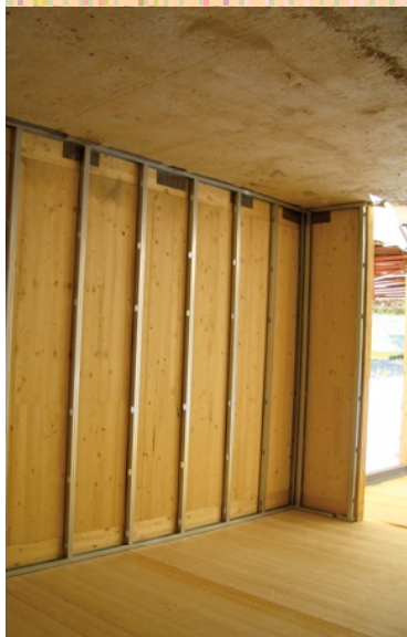
Altre immagini della visita del 7 aprile: a sinistra i profili per le lastre in cartongesso, sopra una veduta esterna del cantiere e, a destra, l'arch. Lorenza De Agostini illustra le peculiarità tecniche del progetto
